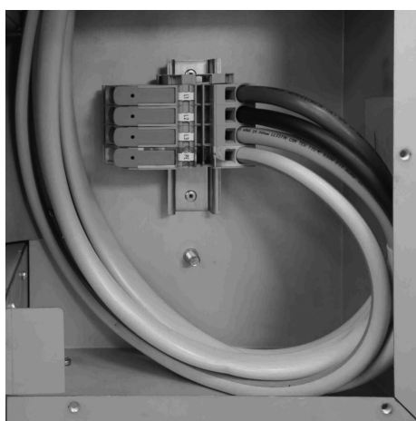
Abb. 22: Klemmen in der Anschlussbox
